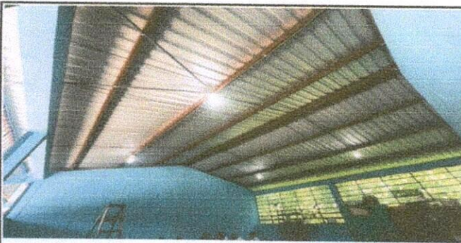
Foto 5 Reparación de Sistema Eléctrico
