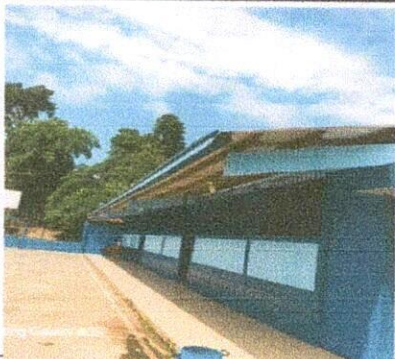
Foto 15 Sustitución de pintura de exterior e interior de aulas
