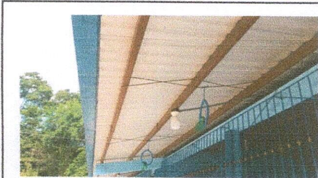
Foto 13 Reparación de Sistema Eléctrico exterior
