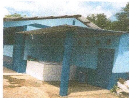
Foto 16 Sustitución de pintura de exterior e interior de cocina
