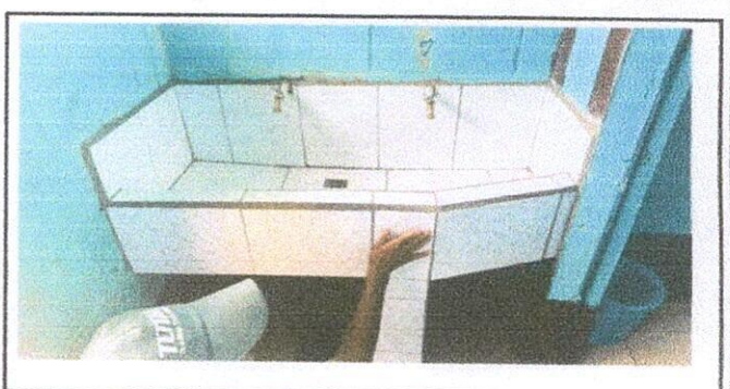
Foto 12 Sustitución de lavamanos
