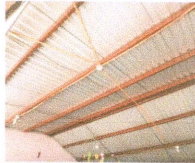
Foto 14 Reparación de Sistema Eléctrico interior
