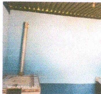
Foto 18 Pintura de interior de cocina
