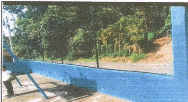
Foto 9 Sustitución de malla, pintura de muro interior y exterior
