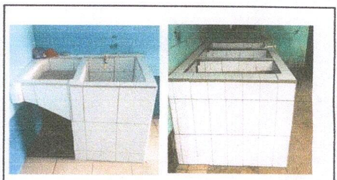
Foto 10 Sustitución de pila y azulejo, pila de cocina y pila de patio
